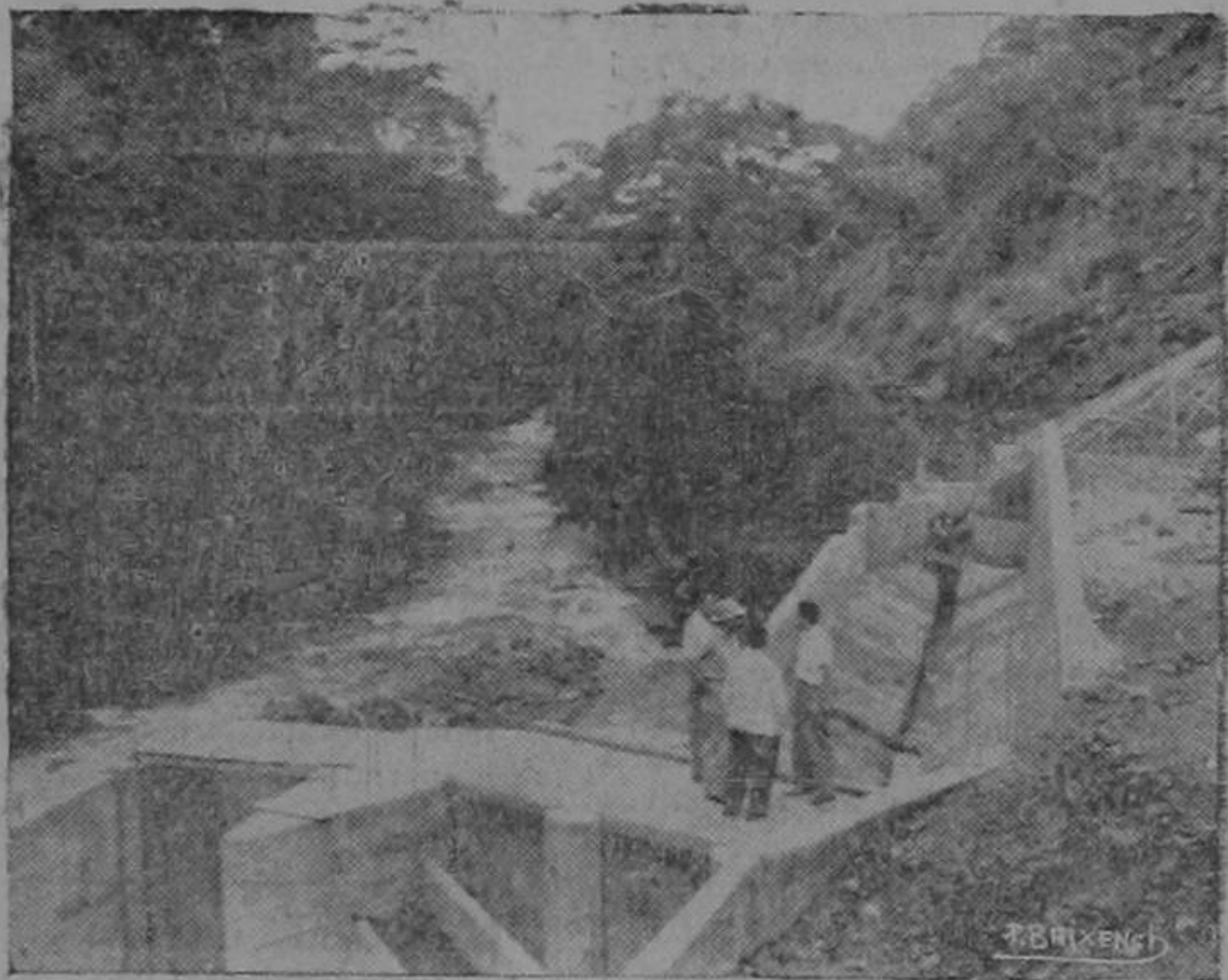
Toma de agua y desarenador
